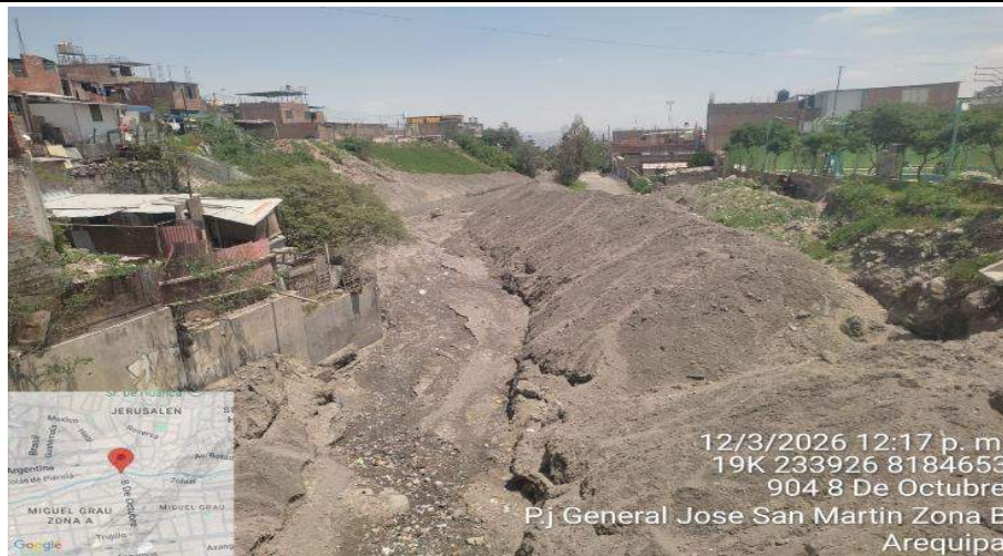
IMAGEN 01: SE OBSERVA LA MARGEN DERECHA QUE REQUIERE DE DESCOLMATACION Y CONSTRUCCION DE MURO DE CONCRETO ARMADO
