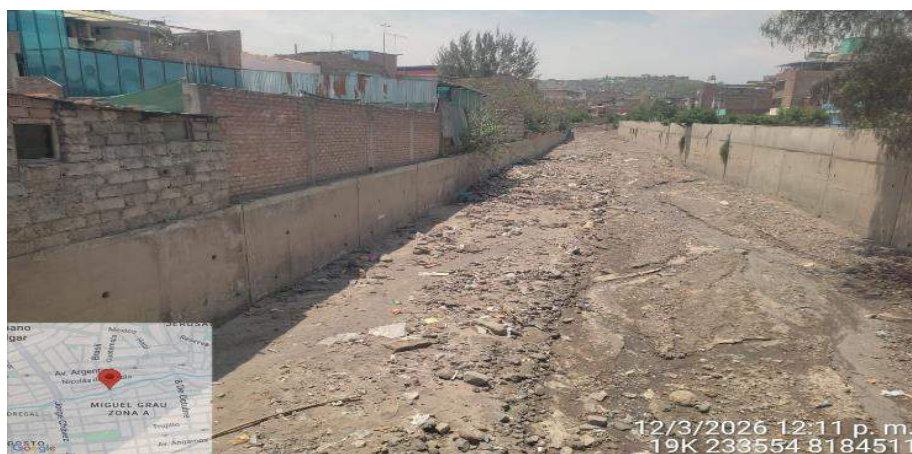
IMAGEN 02: SE OBSERVA LA COLMATACION Y LA DIFERENCIA DE ALTURAS DEL MURO EN AMBAS MARGENES QUE DIVIDE A LOS DISTRITOS DE PAUCARPATA Y MARIANO MELGAR ASI MISMO EN LA MARGEN DERECHA SE MUETRA LAS VIVIENDAS COLINDANTES AL MURO DE MENOR ALTURA
